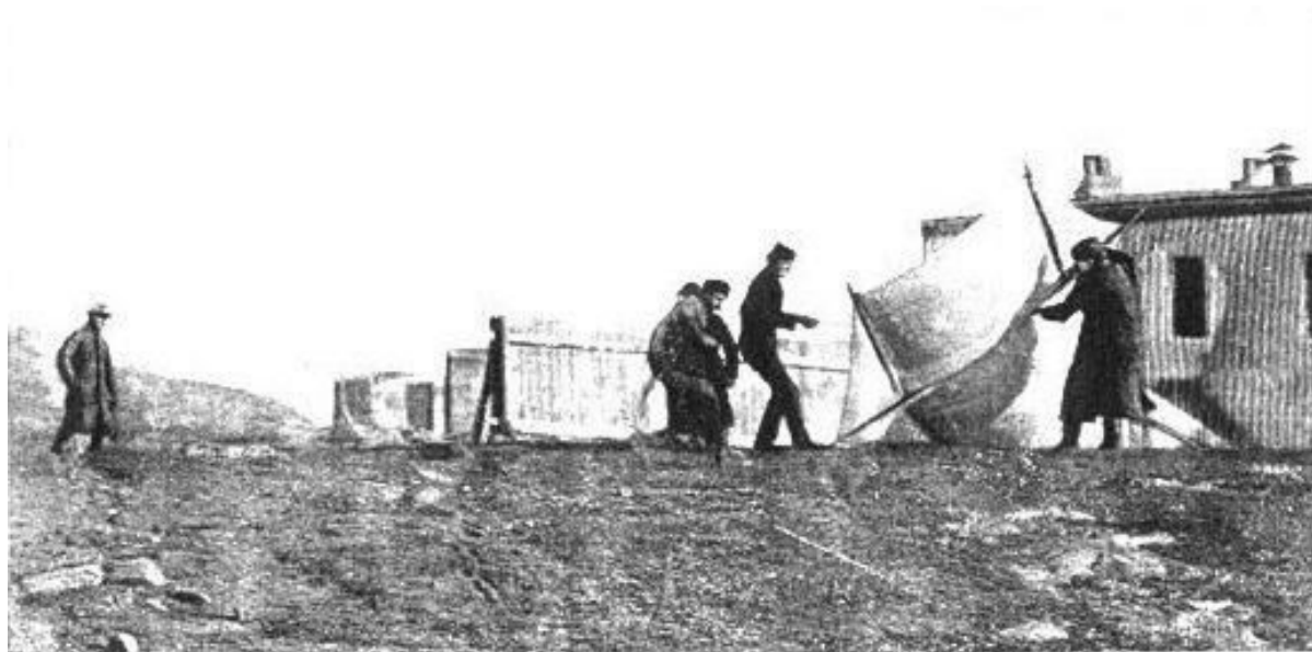
Marconi i pracownicy instalujący anteny w Nowej Fundlandii
