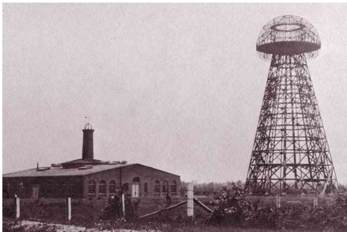
Wieża w Wardencllyffe
